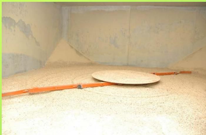
Die Wärmeerzeugung erfolgt durch einen Biomassekessel mit 400 kW Leistung. In die Heizzentrale integriert ist ein Pelletsbunker mit einer Lagerkapazität für 40 to Pellets.
